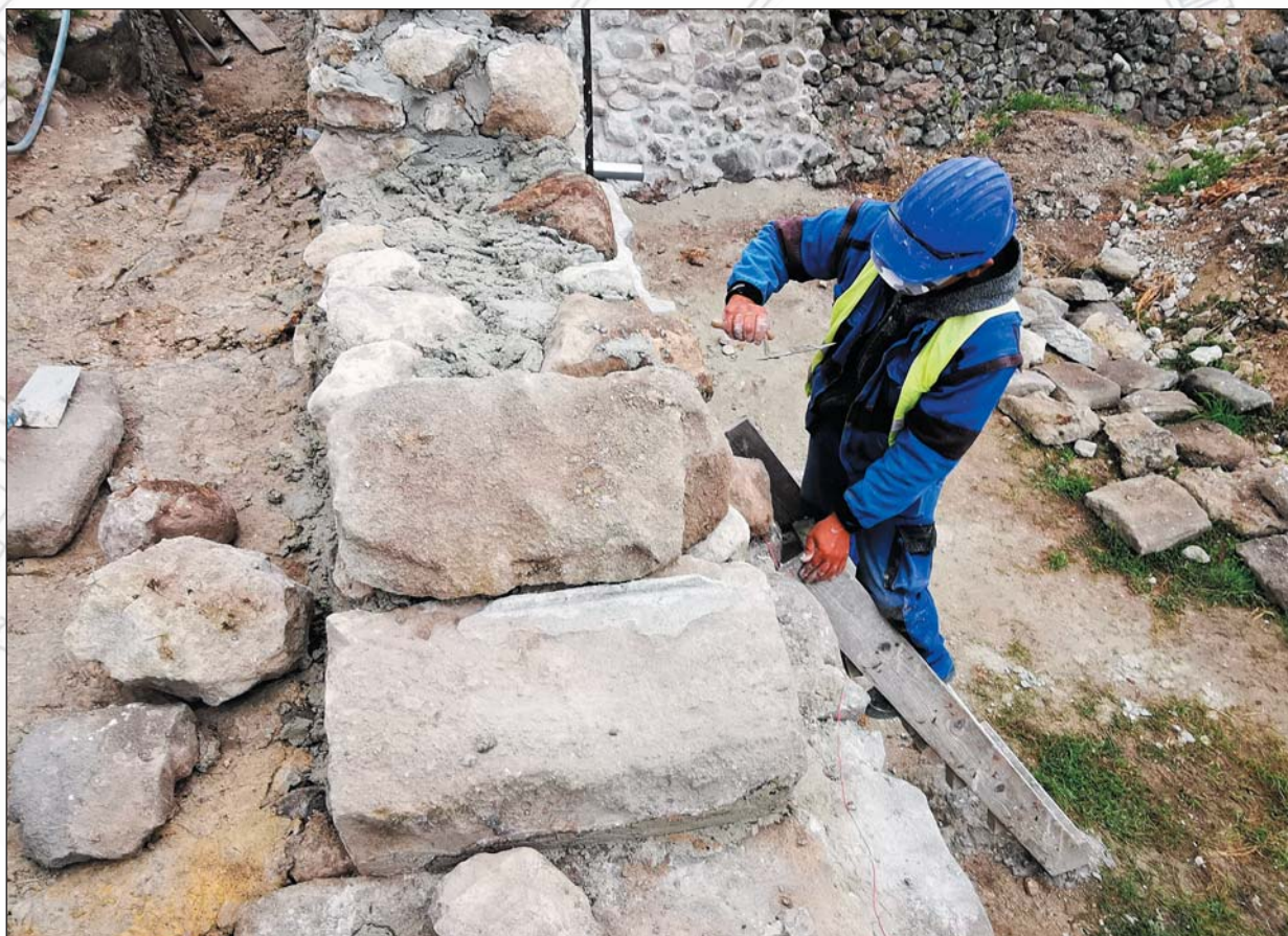
Obr. 22 Montáž schodiskových stupnic
