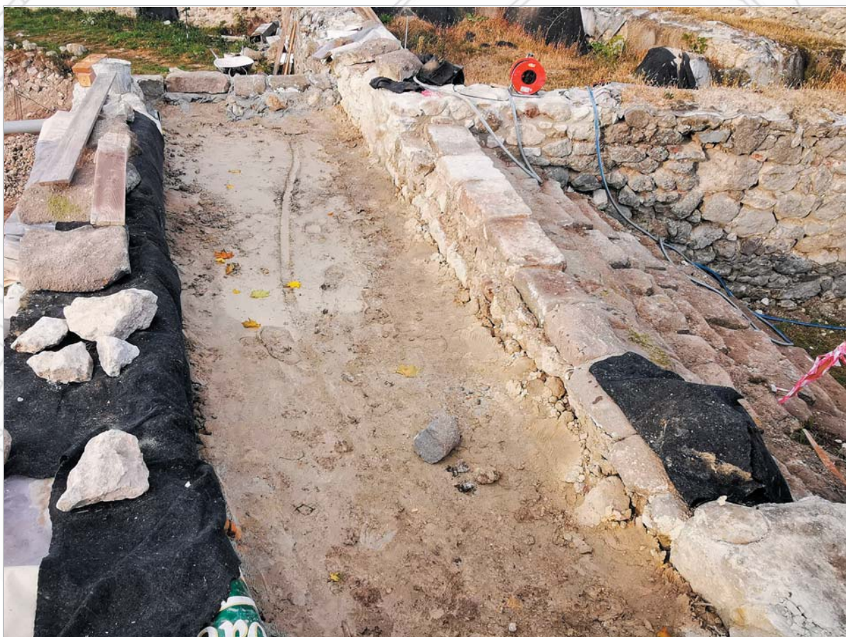
Obr. 35 Zhutnené ílové tesnenie pred zásypom zeminou
