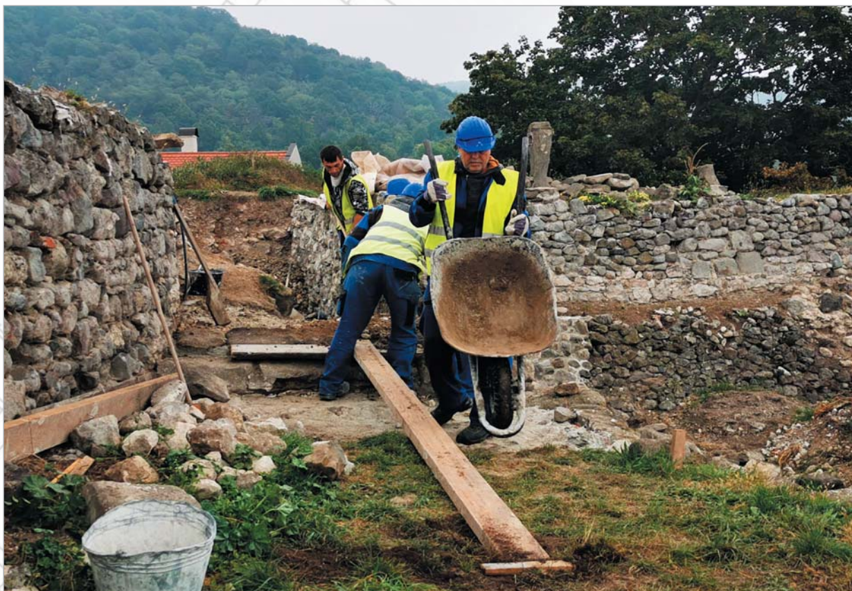
Obr. 32 Montáž ílového tesnenia po oprave muriva - zrealizovaná hydroizolácia zhutneným ílovým tesnením s odvedením zrážkových vôd, (október 2019) pred dokončovacími prácami (zásyp zeminou, zatrávnenie pochôdznej plochy)
