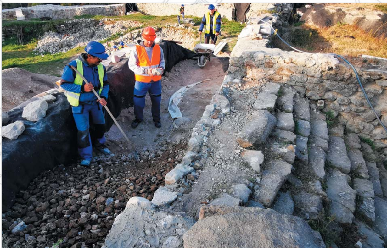
Obr. 33 Montáž ílového tesnenia po oprave muriva - zrealizovaná hydroizolácia zásypmi ílu a jeho následným vlhčením a zhutnením (Obr. 34) a odvedením zrážkových vôd, (október 2019) pred dokončovacími prácami (zásyp zeminou, zatrávnenie pochôdznej plochy)
