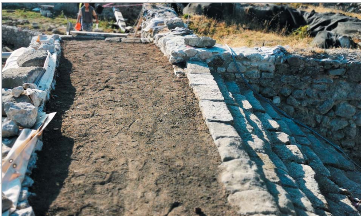
Obr. 36 Zásyp ílového tesnenia zeminou
