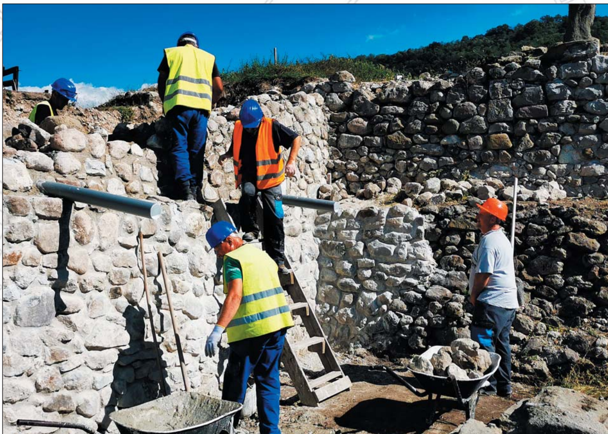
Obr. 18 Stavebné práce pri obnove muriva
