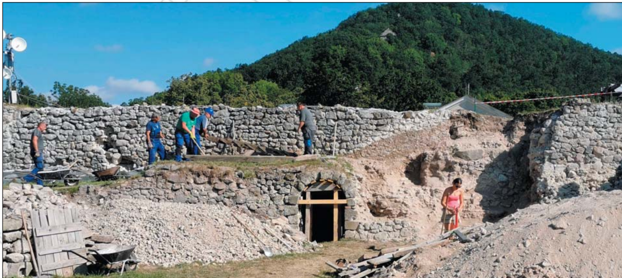
Obr. 9 Začiatok obnovy zrútených častí novovekých parkových úprav - zemné práce
