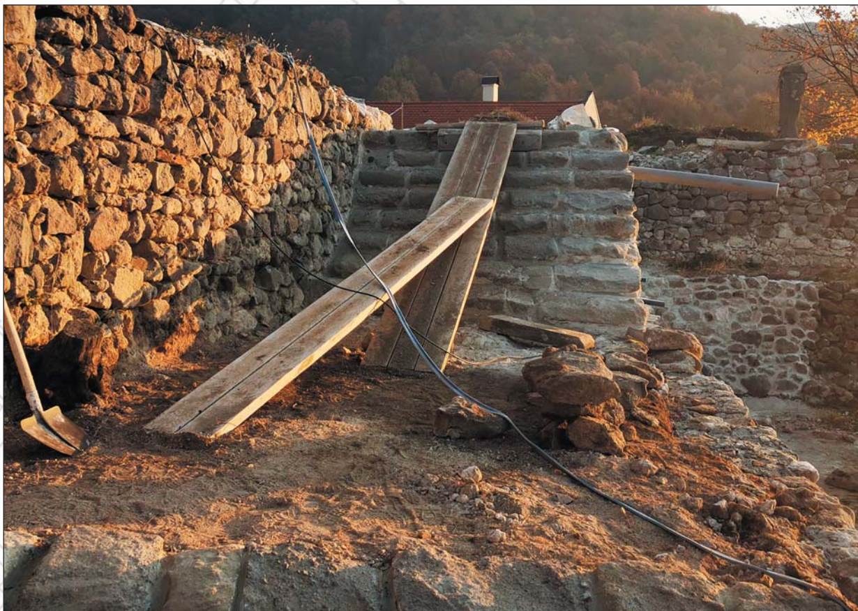
Obr. 25 Obnovené obvodové murivo a schodisko
