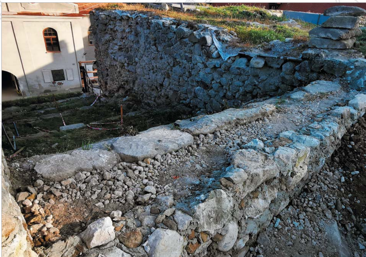
Obr. 32 Sanácia oporného muriva hlavného schodiska
