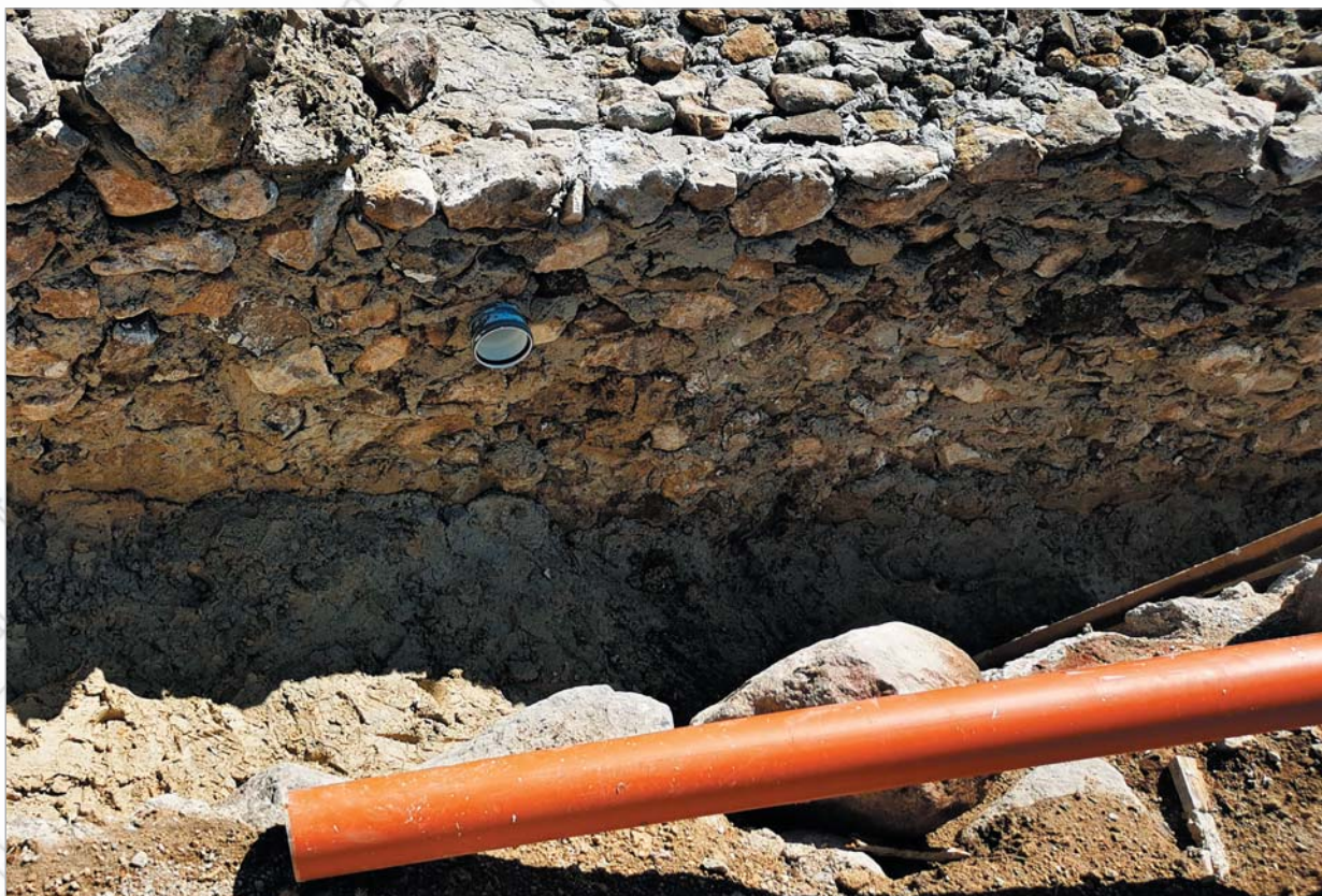
Obr. 31 Montáž ílového tesnenia po oprave muriva - zrealizovaná hydroizolácia zhutneným ílovým tesnením s odvedením zrážkových vôd, (október 2019) pred dokončovacími prácami (zásyp zeminou, zatrávnenie pochôdznej plochy)
