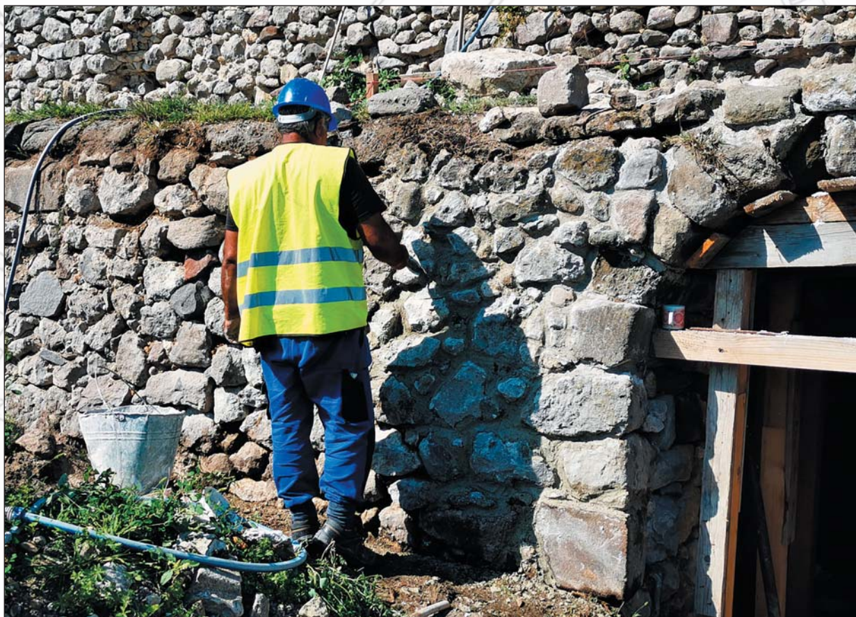
Obr. 20 Stavebné práce pri obnove muriva. Hĺbkové škárovanie existujúceho muriva
