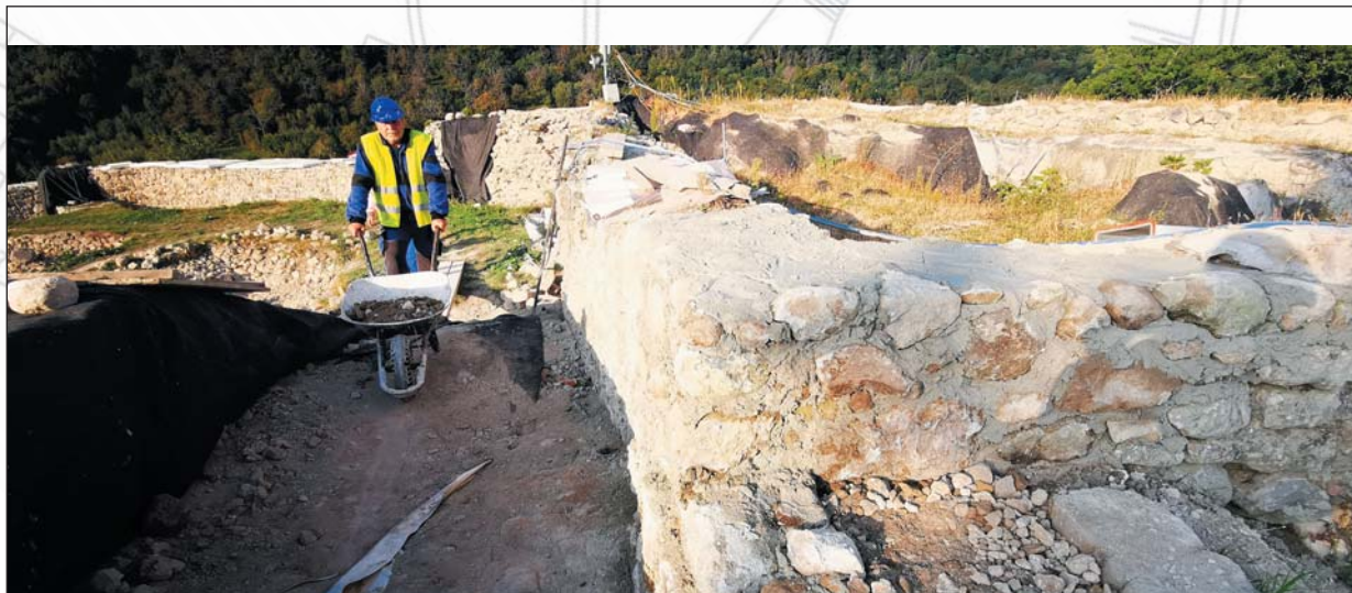
Obr. 30 Montáž ílového tesnenia po oprave muriva - presun hmôt
