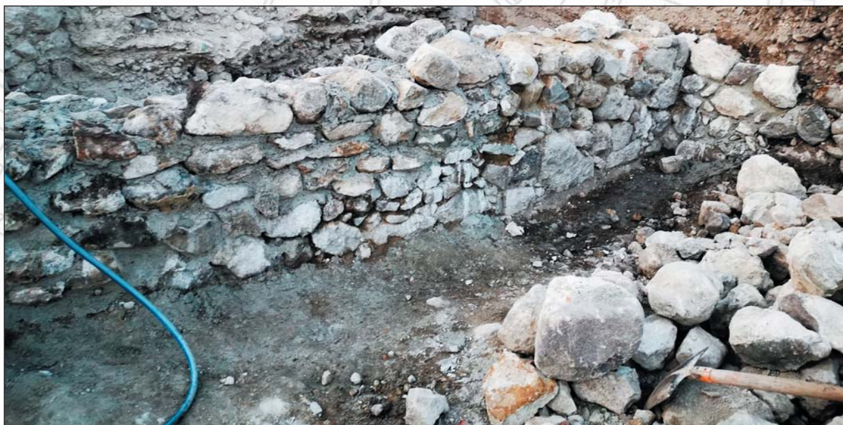
Obr. 14 Pohľad na novo založené murivo
