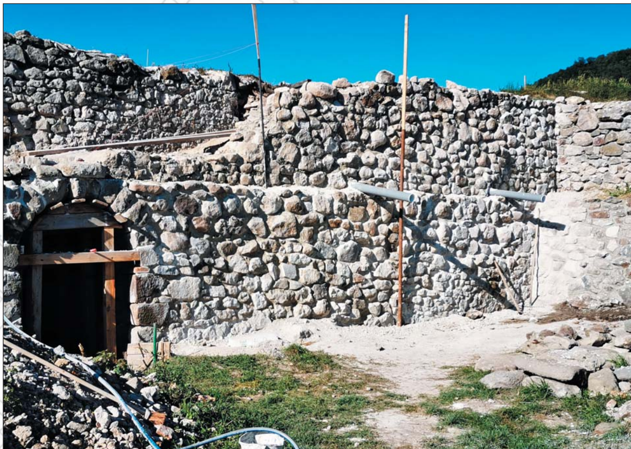
Obr. 19 Stavebné práce pri obnove muriva
