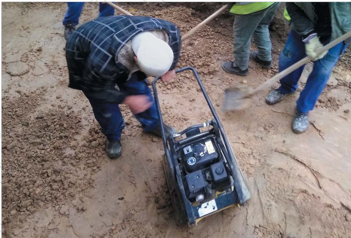
Obr. 34 Zhutňovanie ílového tesnenia vibračnou doskou
