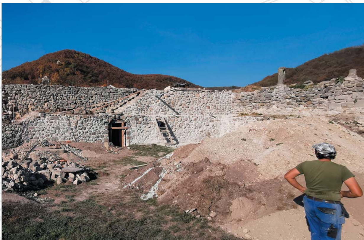
Obr. 28 Obnovené obvodové murivo a schodisko. Stav v októbri 2019
