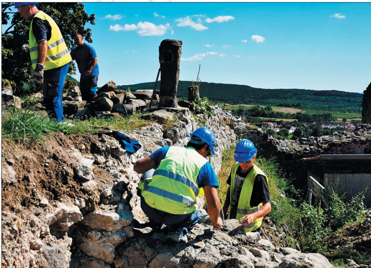
Obr. 17 Stavebné práce pri obnove muriva
