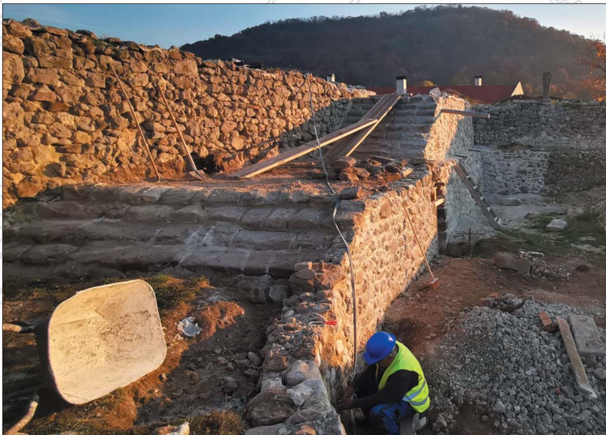
Obr. 26 Obnovené obvodové murivo a schodisko. Dokončovacie práce - hĺbkové škárovanie
