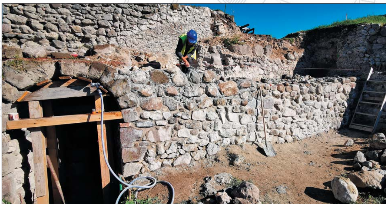
Obr. 16 Stavebné práce pri obnove muriva
