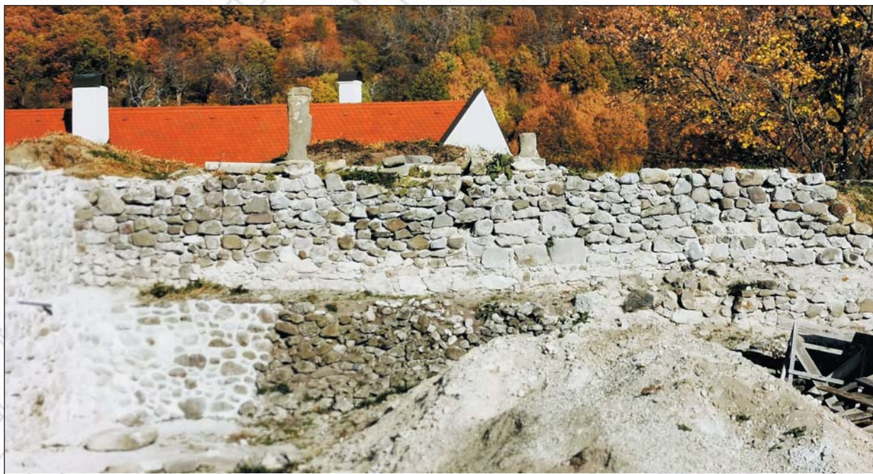
Obr. 27 Pohľad na obnovené obvodové murivo SV terasy v roku 2019 a časti, ktoré je potrebné opraviť.
