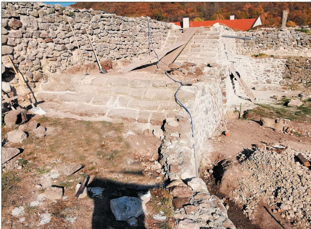
Obr. 24 Obnovené schodiskové stupnice - celkový pohľad
