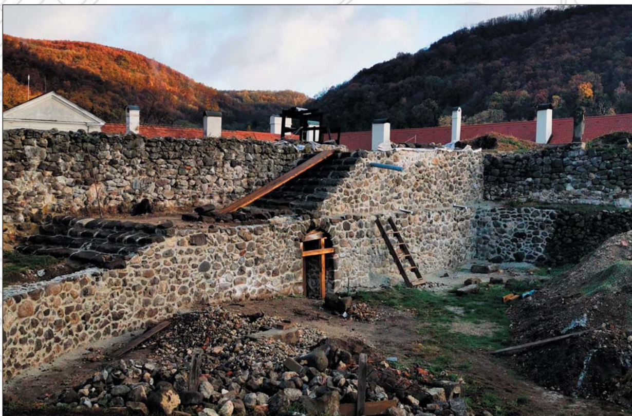
Obr. 37 Obnovené obvodové murivo a schodisko. Stav k ukončeniu etapy v novembri 2019
