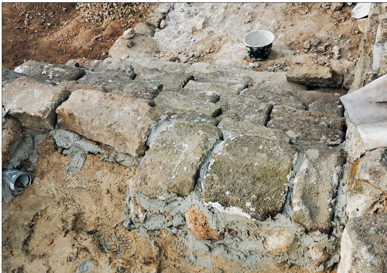
Obr. 23 Obnovené schodiskové stupnice
