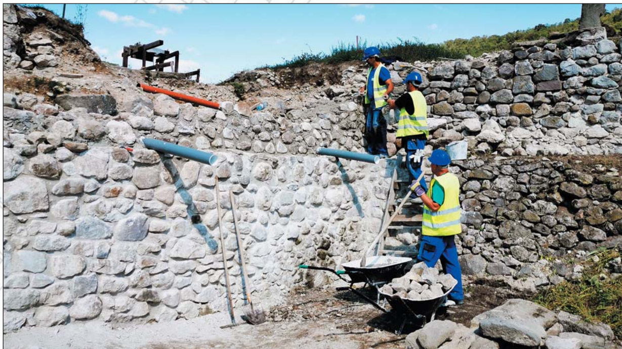
Obr. 29 Montáž odvodňovacích prvkov pri oprave muriva - zrealizovaná hydroizolácia zhutneným ílovým tesnením s odvedením zrážkových vôd, rúrami
